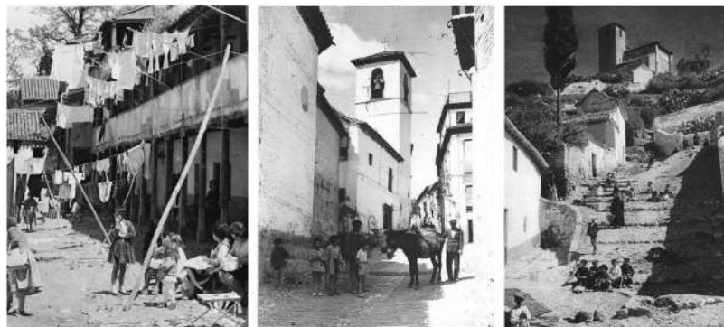
Vecindad del Albaicín (s.f.) / Iglesia de San José con su anexo antes de ser derribado, Torres Balbás (ca. 1930) / Subida a San Miguel Alto (s.f.)
