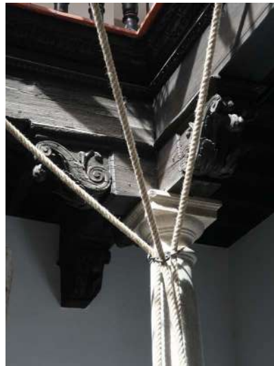
Argolla de tres lóbulos durante el montaje del ensamblaje. Operaciones Cunctatio, abril de 2023
