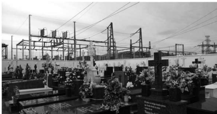
Cementerio de El Fargue y estación eléctrica. Photolanda (2016)
