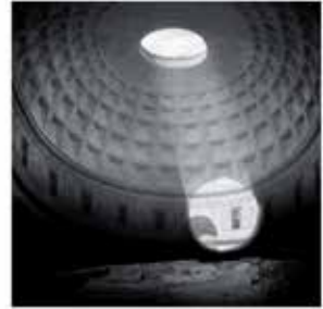
Interior de la estructura de hormigón armado y el sistema de drenaje de agua.
