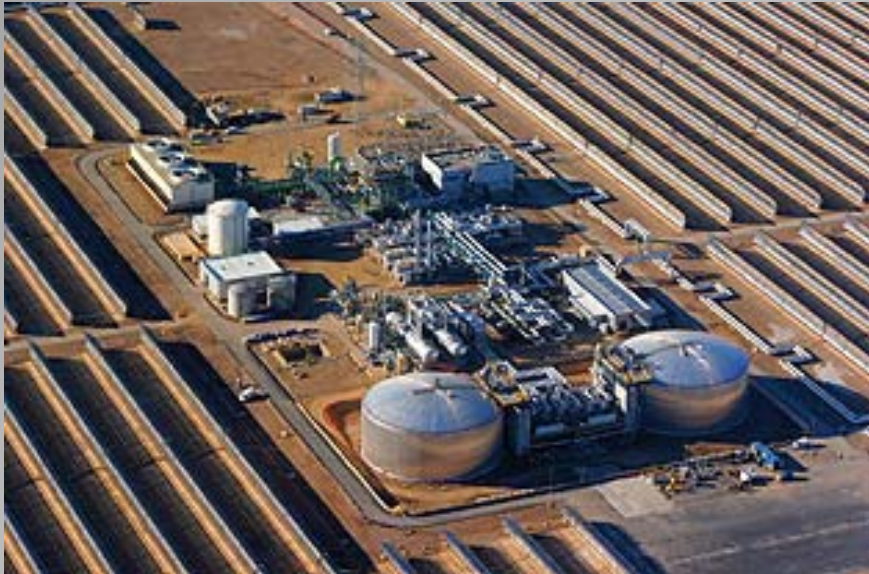
CENTRAL SOLAR DE ANDASOL EN ALDEIRE (GRANADA)
