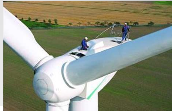
DETALLE DE UN AEROGENERADOR
